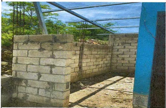
Foto 3: MEJORAMIENTO E INSTALACION DE TECHO DE COCINA, PISO Y PUERTA
