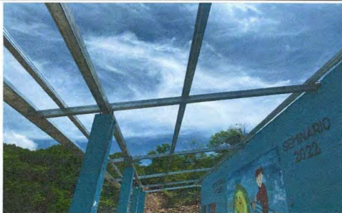
Foto 2: MEJORAMIENTO E INSTALACION CAMBIO DE TECHO
