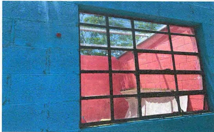
Foto 1: MEJORAMIENTO E INSTALACION DE VENTANAS DE PVC
