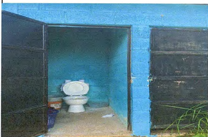
Foto 4: REMOZAMIENTO DE BAÑOS, PINTURA Y PISO
